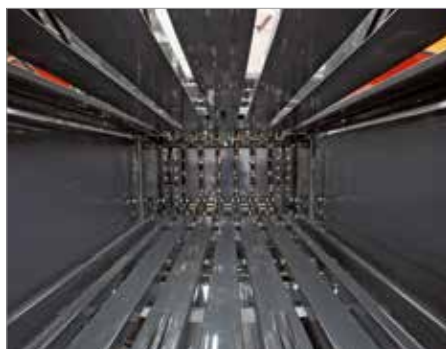
4. Автоматичне регулювання тиску
