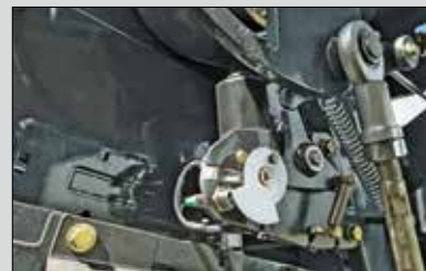
Электрическая система обвязки
