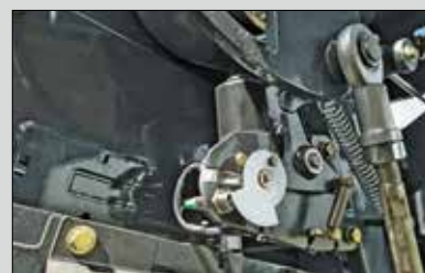
Электрическая система обвязки
